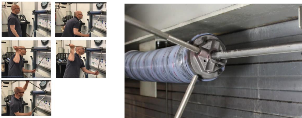
Figuur 1 Handmatig opspannen van een veer van een overhead deur (rechts: detail)
